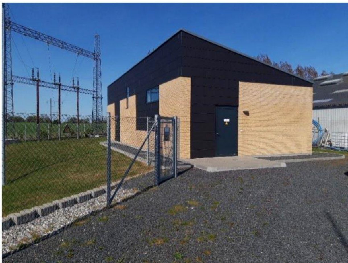
Eksempel på lignende transformerstation – nærværende projekt vil få samme udtryk
